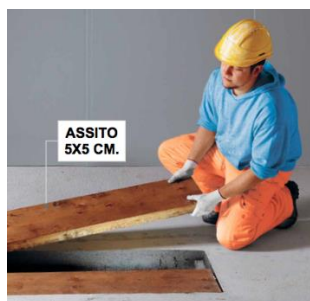
Immagine 1,2,3 - Si visualizza esempio di applicazione impalcato a segregazione dell'apertura
